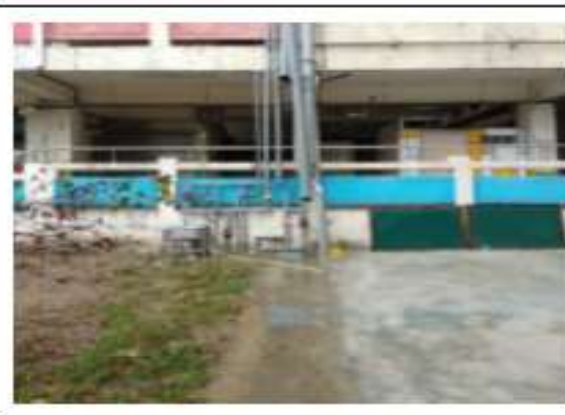
移走水塔並鋪上水泥，且加裝定時開關自動澆水
